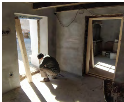
Inštalácia dverí a zárubní
