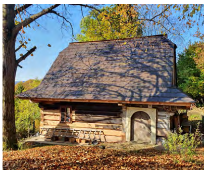
Zákopčie (Kysuce), výnimočná obnova zrubového domu a jeho využívanie na rekreáciu, národná kultúrna pamiatka.
