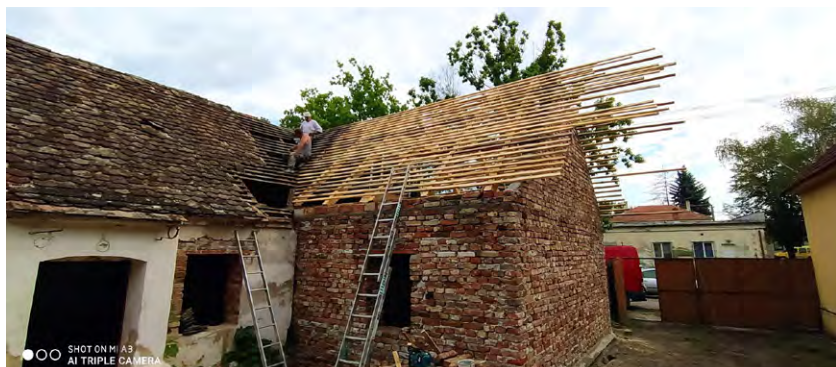
Dom 1890, 17. 8. 2020 – Dokončovanie krovu
