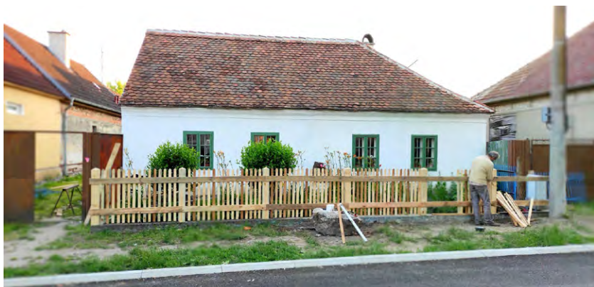
Stavba dreveného plotá
