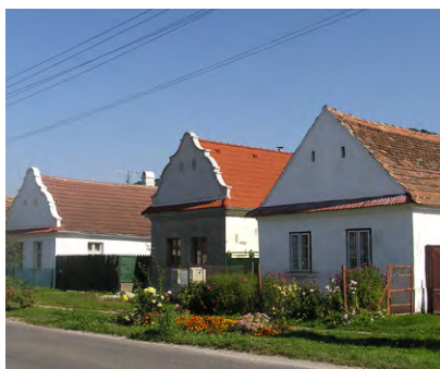
Plavecký Peter (Záhorie), pamiatková rezervácia ľudovej architektúry s unikátne zachovaným súborom murovaných obytných domov.
