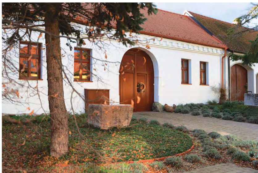
Dolany (Malokarpatská oblasť), výnimočná obnova murovaného vinohradníckeho domu, zatiaľ bez úradnej pamiatkovej ochrany.
