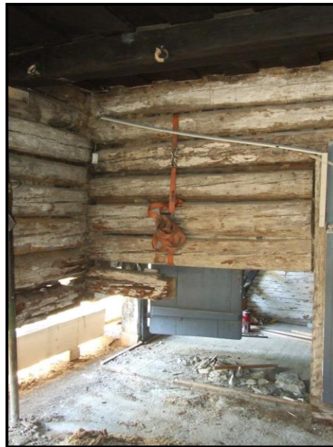
ČIČMANY, zrubový dom č. 42, výmena spodných poškodených trámov
