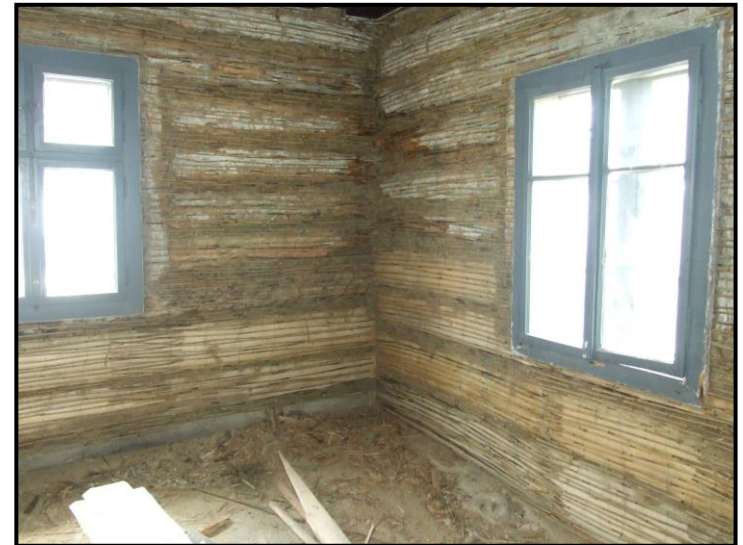
ČIČMANY, zrubový dom č. 42, výmena spodných poškodených trámov
