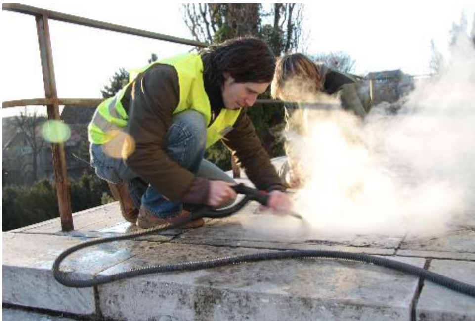
Test odstraňování nečistot z povrchu kamene pomocí tlakové páry
