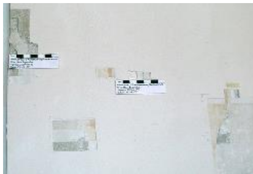
Sondáž povrchových úprav na interiérových omítkách
