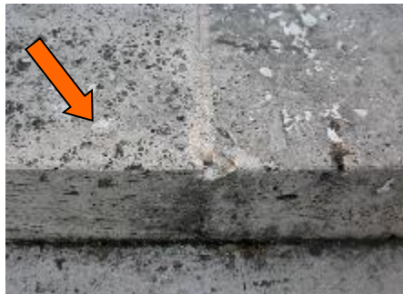
Bílý tmel použitý na doplnění chybějících míst a na spárování
