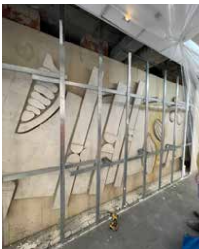
Postupná demontáž sadrokartónovej steny Zdroj: Archív Mondelez SR Production
