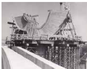
Rovnováha, Barrandovský most, proces stavby Autor: Josef Klimeš Fotografie: z pozůstalosti autora
