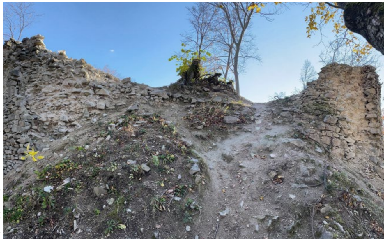
Západný palácový múr – porovnanie pôvodného a aktuálneho stavu
