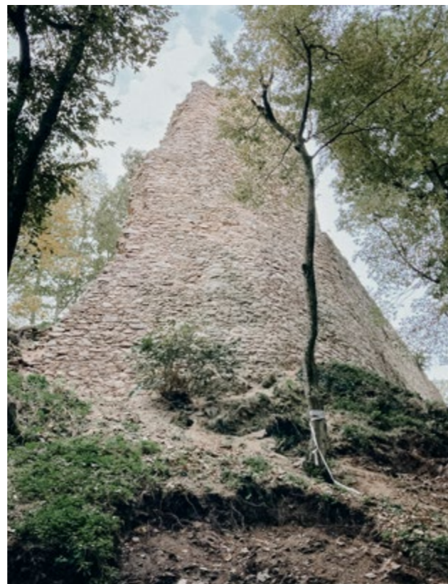
Západná obranná veža – porovnanie pôvodného a aktuálneho stavu
