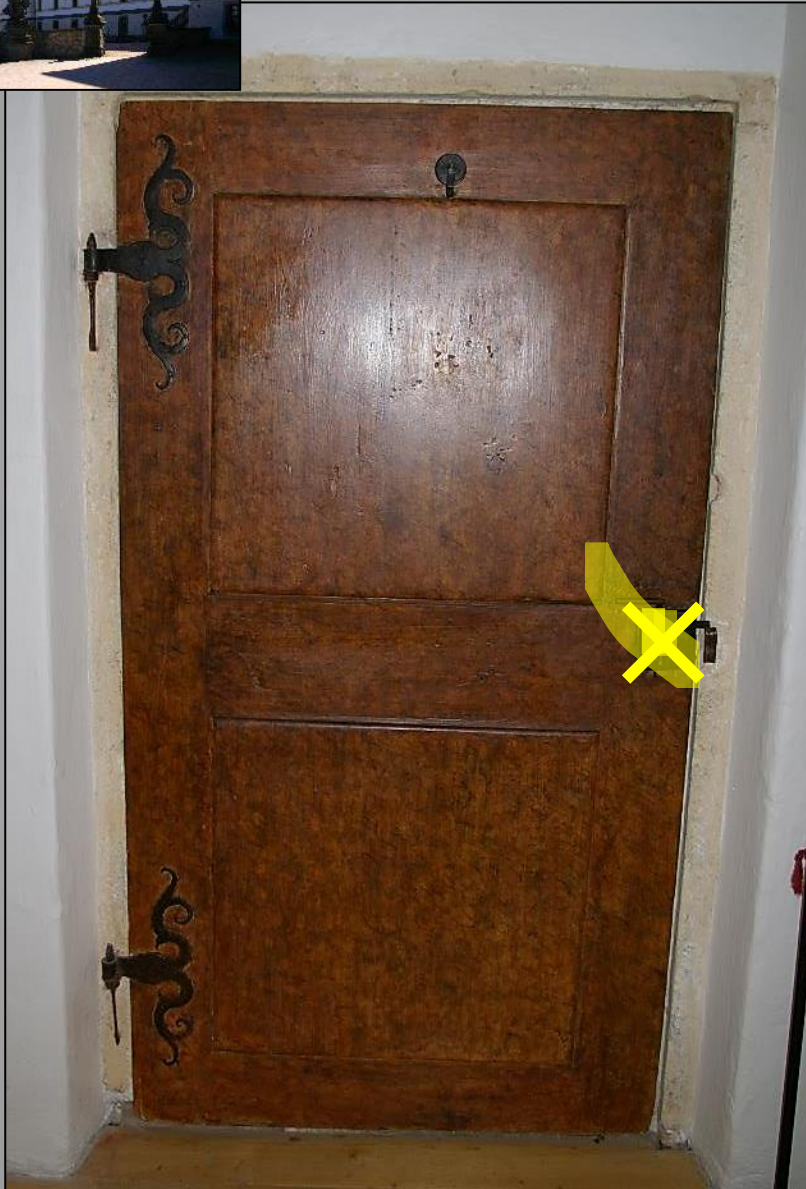
Kuks (ČR), Hospital, rôzne rámové dvere/drážka, polodrážka – závesy/zámky/držadlo (po r. 1700, Ľ. Suchý, 2012)
