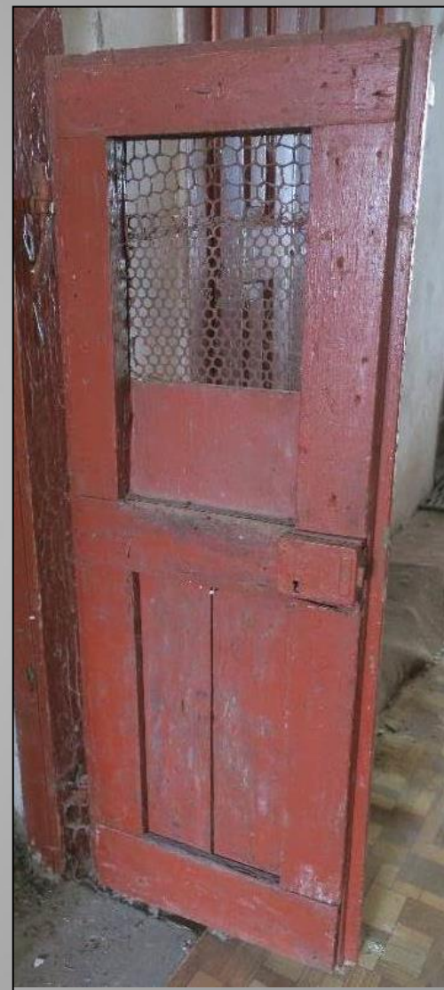
Esový záves, sekundárne využitý (rám krídla) s kovaným dverným hákom (zárubňa) - 18./19. st.
