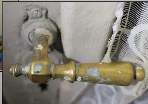
Vonkajší rohový záves presklenej výplne a zapustený záves dverí (puzdrá ukončené žalud'mi)
