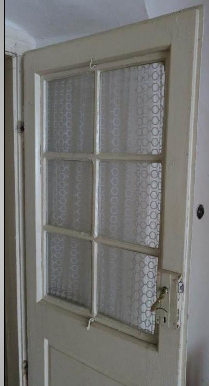
Rub dverí s odnímateľnou presklenou časťou
