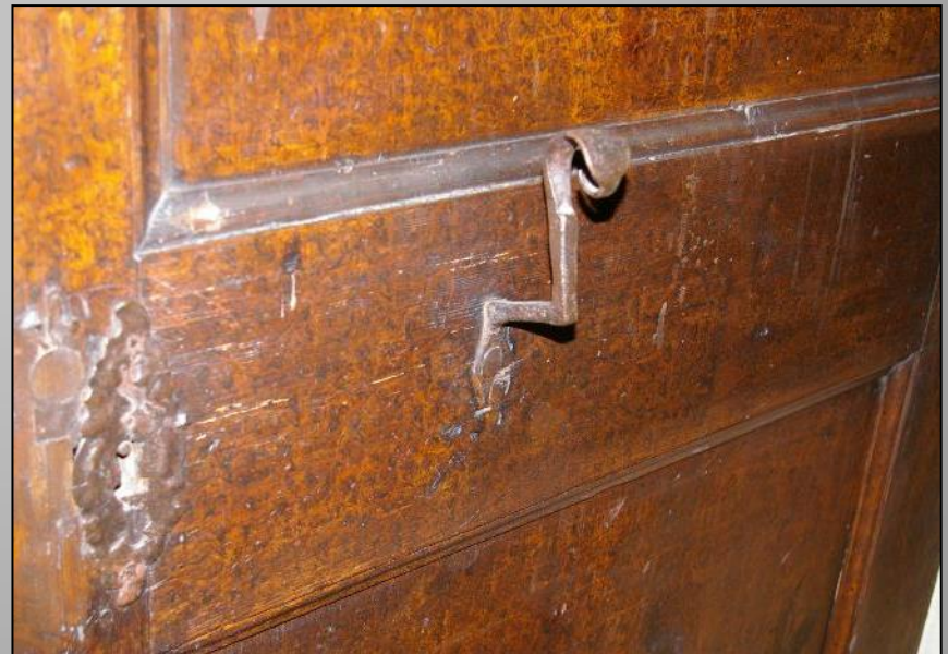
Kuks (ČR), Hospital, rôzne rámové dvere/drážka, polodrážka – závesy/zámky/držadlo (po r. 1700, Ľ. Suchý, 2012)
