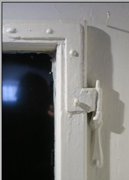
Vonkajší rohový záves presklenej výplne a zapustený záves dverí (puzdrá ukončené žalud'mi)
