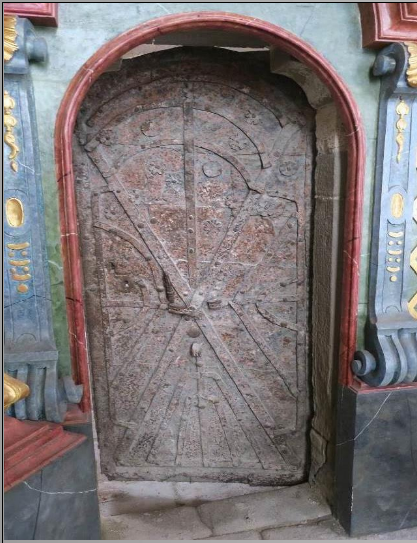
Líc-konštrukcia zo železných plátov vystužených pásovinou (14./15. st.)
