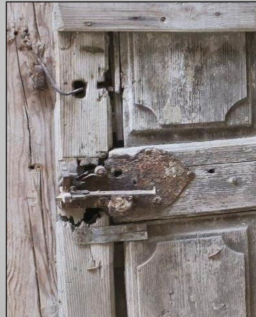
Barokový zámok s otvorenou mechanikou na nosnej plechovej podložke (18. st.)
