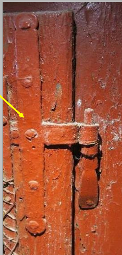
Krížový záves (rám krídla) s kovaným dverným hákom/závesníkom (zárubňa) pol. 19. st.
