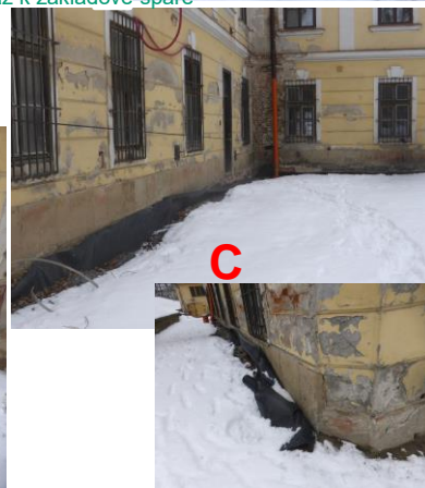
A velmi kvalitně postavený zámek B neúspěšné odvlhčení nevětranou dutinou C ve velkém rozsahu proveden kanál s drenáží a nopovou fólií až k základové spáře
