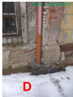
D závady v odvodnění n
