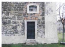
fotodokumentace statické průzkumy archivní rešerše stav. historický průzkum průzkum zdiva
