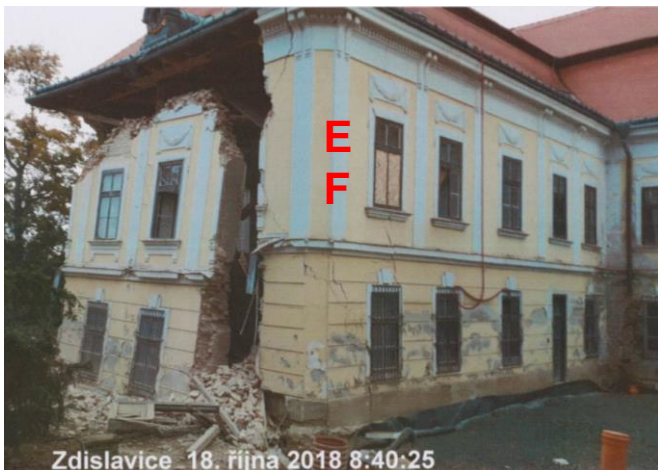
E poslední úsek byl proveden bagrem bez pažení F nesoudržná zemina pod základem se usmykla
