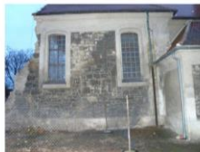
1) překročení pevnosti zdiva
