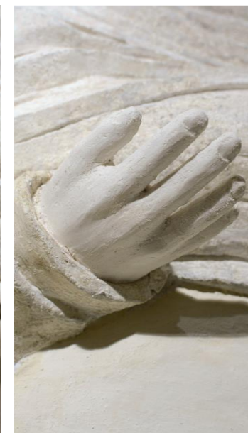
Plasticita vápenných malt při modelaci plastických doplňků. Rekonstrukce štukového epitafu, Český Rudolec. Foto: K. Šibravová.
