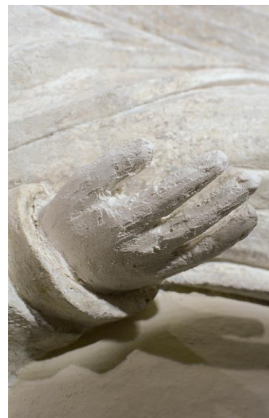
Plasticita vápenných malt při modelaci plastických doplňků. Rekonstrukce štukového epitafu, Český Rudolec. Foto: K. Šibravová.
