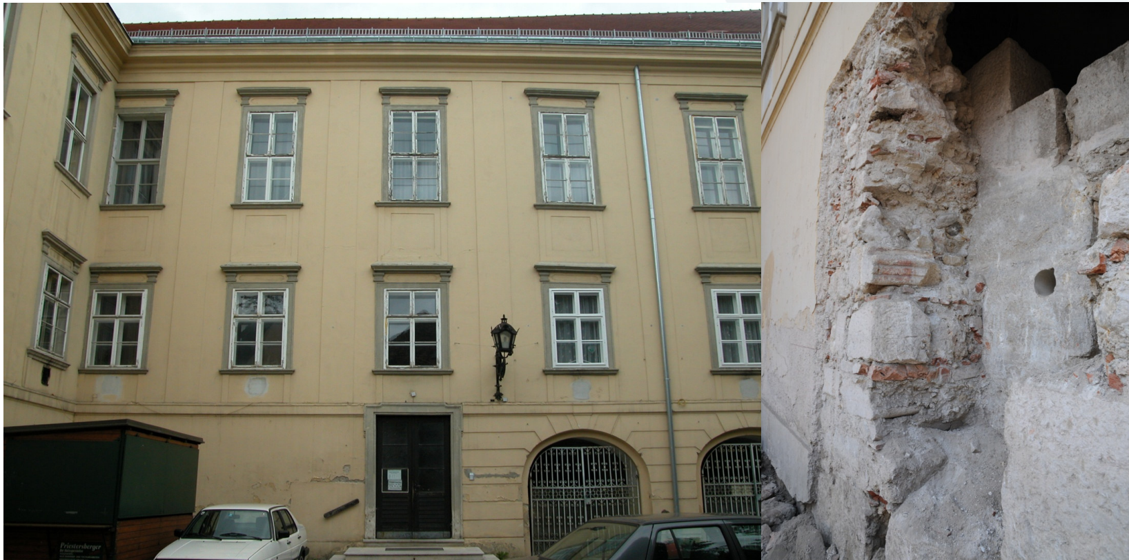
Beispiel Baubegleitung → 2m dicke Mauer, dahinter Quadermauerwerk
