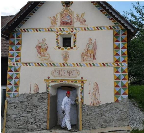
Der Mauersockel hatte eine technische Funktion (Entwässerungs-, Trocknungs- und Reparaturzone), die sich zu einem architektonischen Element entwickelte. Der Sockel hat die Funktion, Feuchtigkeit zu verdunsten und das Salz aufzunehmen, bis er mit Salz gefüllt ist und erneuert werden kann. Deshalb ist sie auch häufig vom Gebäude abgesetzt und dunkel gestrichen – Reparaturzone, Schmutz und Schäden sind schwerer sichtbar.
