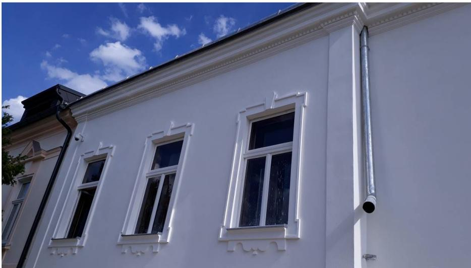
Das Kastenfenster basiert auf der Idee, an einer Zarge zwei Fensterebenen hintereinander zu montieren, um durch den entstehenden Luftzwischenraum eine zusätzliche Wärmedämmung zu erreichen. Durch die Ausbildung einer möglichst stehenden Luftschicht kann so deren relativ niedrige Wärmeleitfähigkeit aktiviert werden.
