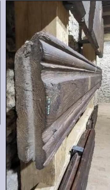
Profilované fošne záklopu/podhľadu trámového stropu na 2. a 3. NP (borovicové drevo) žliabková profilácia
