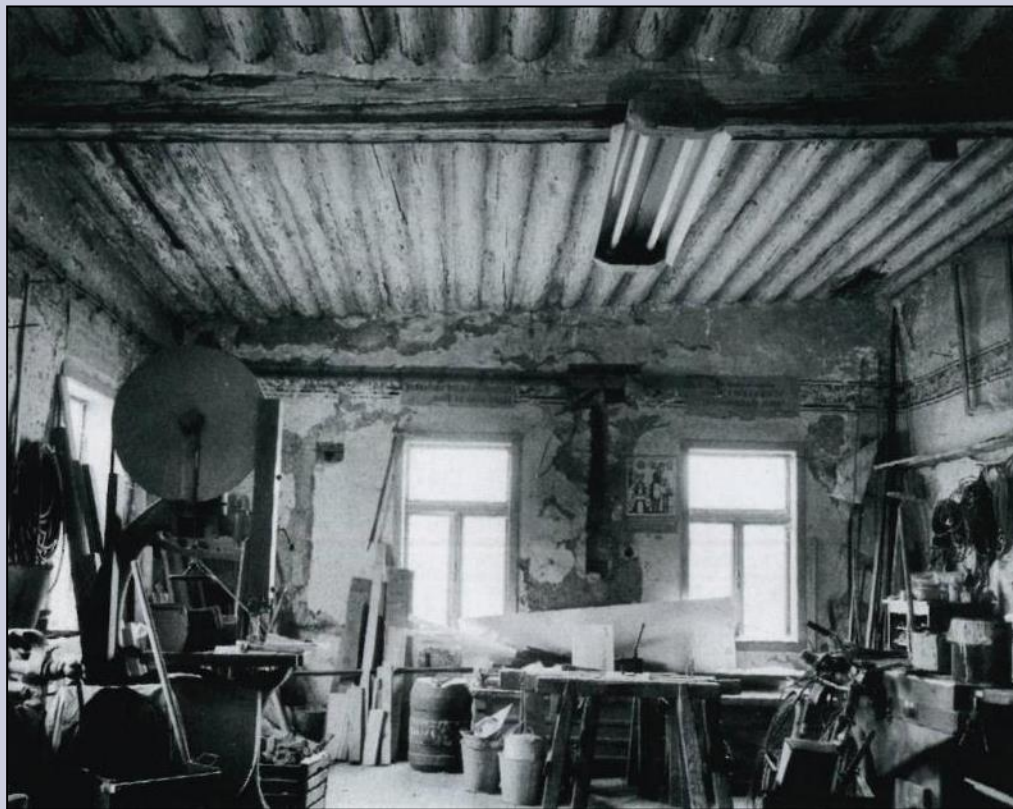
Vračovice u Vysokého mýta, čp. 2 (ČR) zrub s podopretým povalovým stropom (okolo r. 1540)
