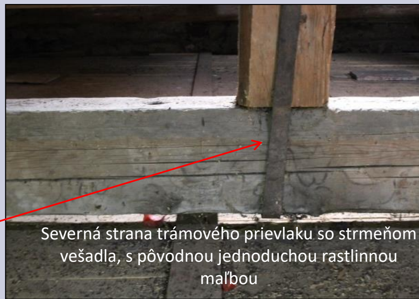
Hambáľkový krov po vložení novej konštrukcie a vešadlo na dnes otočenom trámovom prievlaku stropu nad loďou - pohľad z JZ
