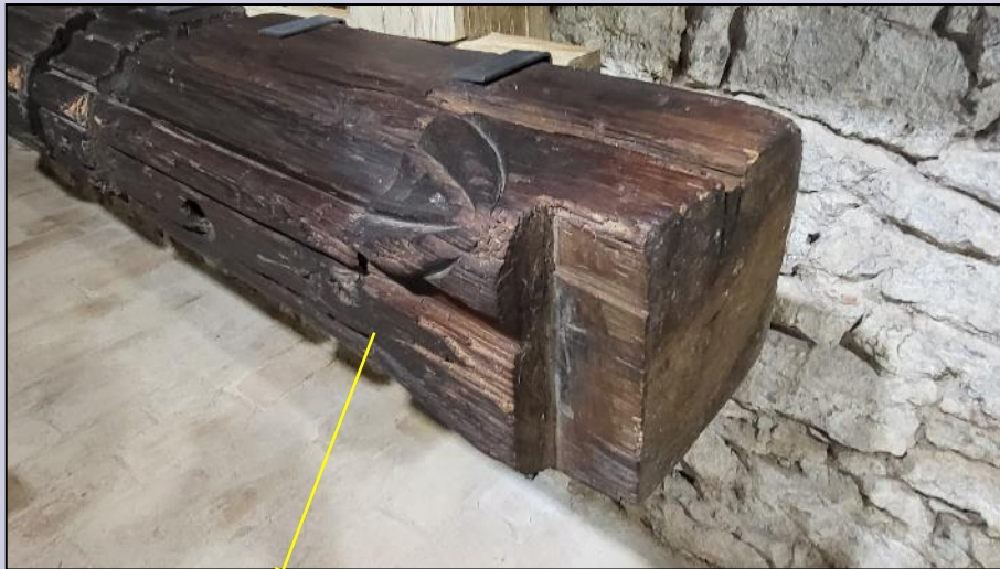
Profilované fošne záklopu/podhľadu trámového stropu na 2. a 3. NP (borovicové drevo) žliabková profilácia
