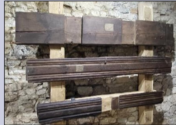
Profilované fošne záklopu/podhľadu trámového stropu na 2. a 3. NP (borovicové drevo) žliabková profilácia
