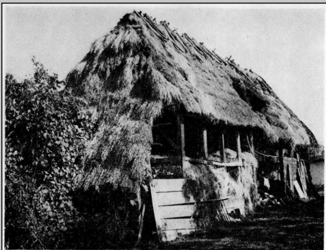
Obr. 19. Sečovská Polianka č. 77, okres Vranov nad Topľou. Šopa stĺpkovo-rámovej konštrukcie s doštenou výplňou v dolnej časti, pokrytá slamenou krytinou. Foto J. Turzo. Fotoarchív SNM-EÚ, Martin, neg. č. 63 127
