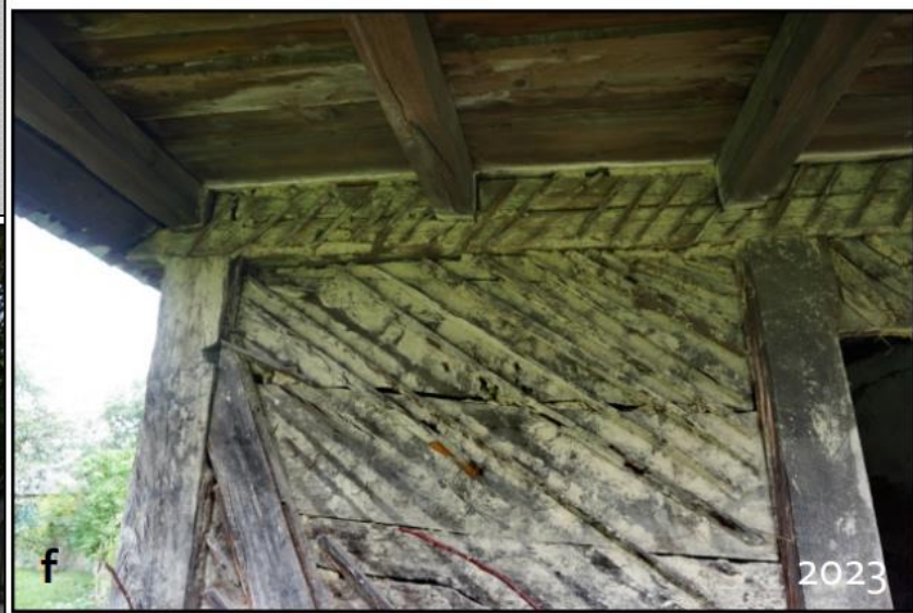
Vyškov, Nova vul. 7 (UA) , detail doskovej výplne, diagonálneho latovania – podklad pod hlinenú omietku) M. Volovár, 2023
