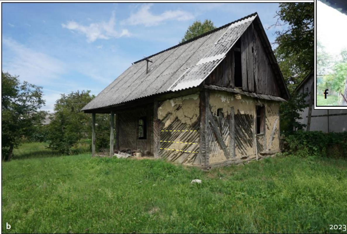
Vyškov, Nova vul. 7 (UA) , detail doskovej výplne, diagonálneho latovania – podklad pod hlinenú omietku) M. Volovár, 2023
