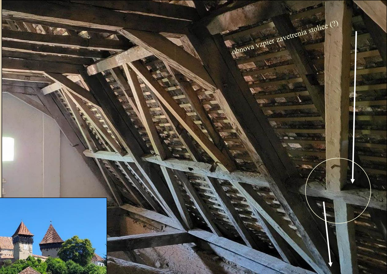
Alma Vii (Rumunsko-Sedmohradsko, župa Sibiu) opevnený Kostol, saský 14. a 16. st. (krov s ležatou stolicou 17./18. st.)
