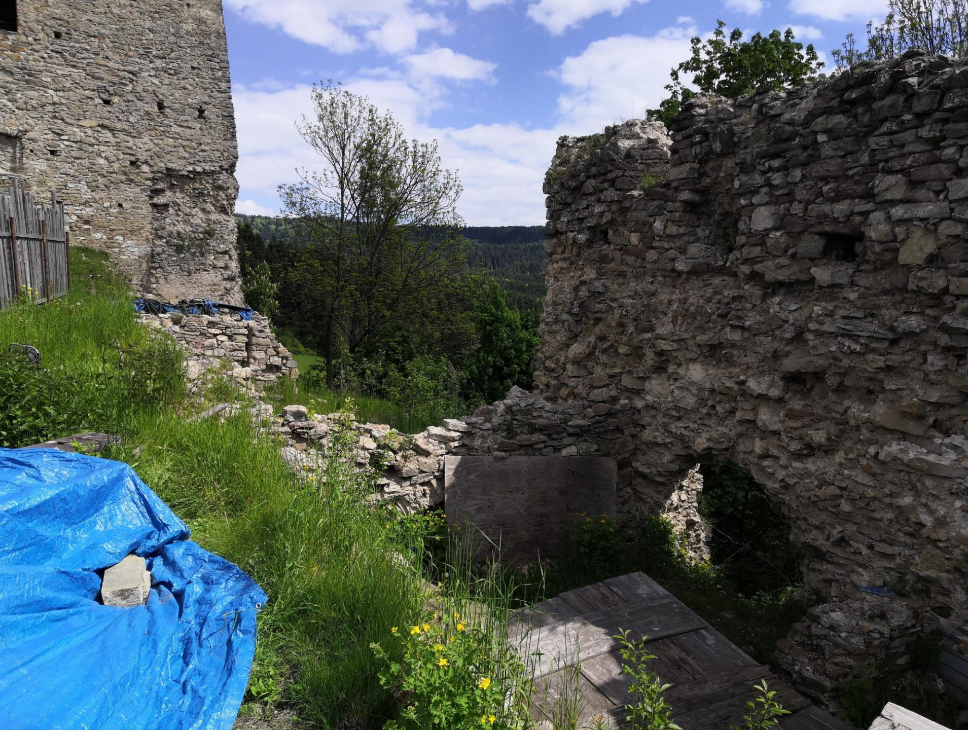
Severozápadná hradba IV. nádvorie hradu Stará Ľubovňa
