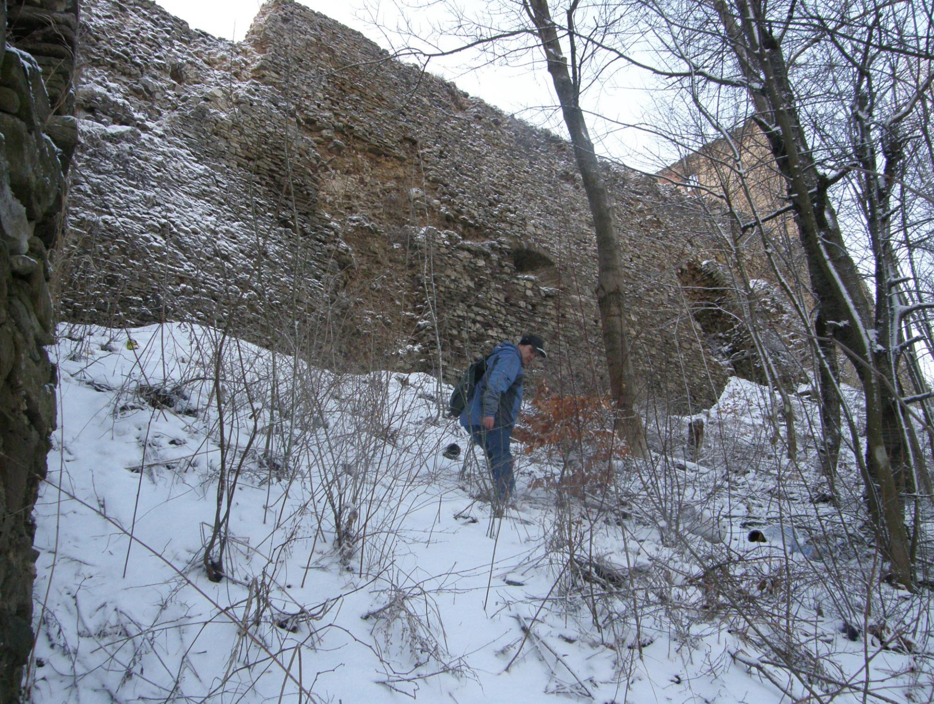
Severozápadná hradba IV. nádvorie hradu Stará Ľubovňa
