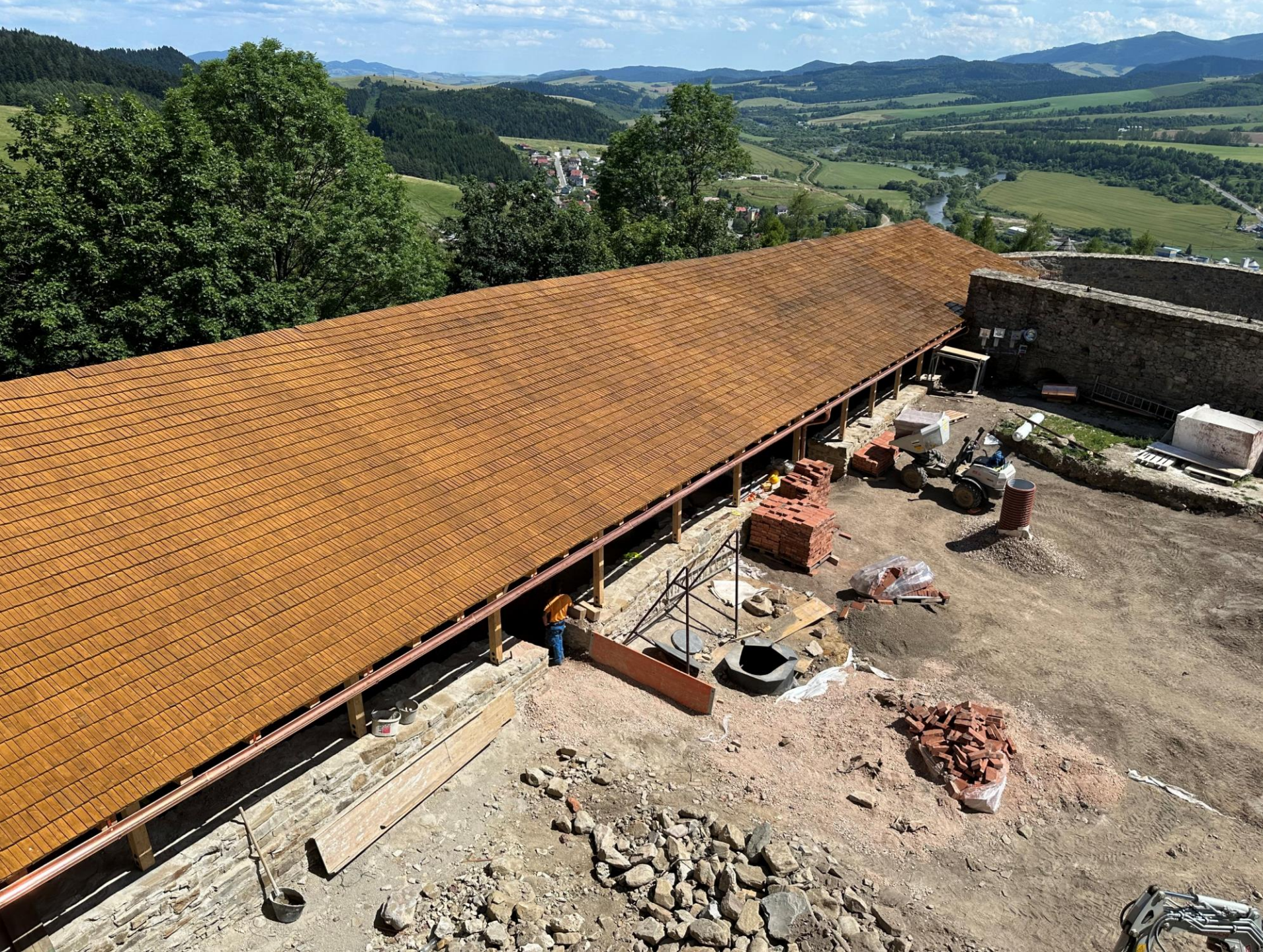
Severozápadná hradba IV. nádvorie hradu Stará Ľubovňa
