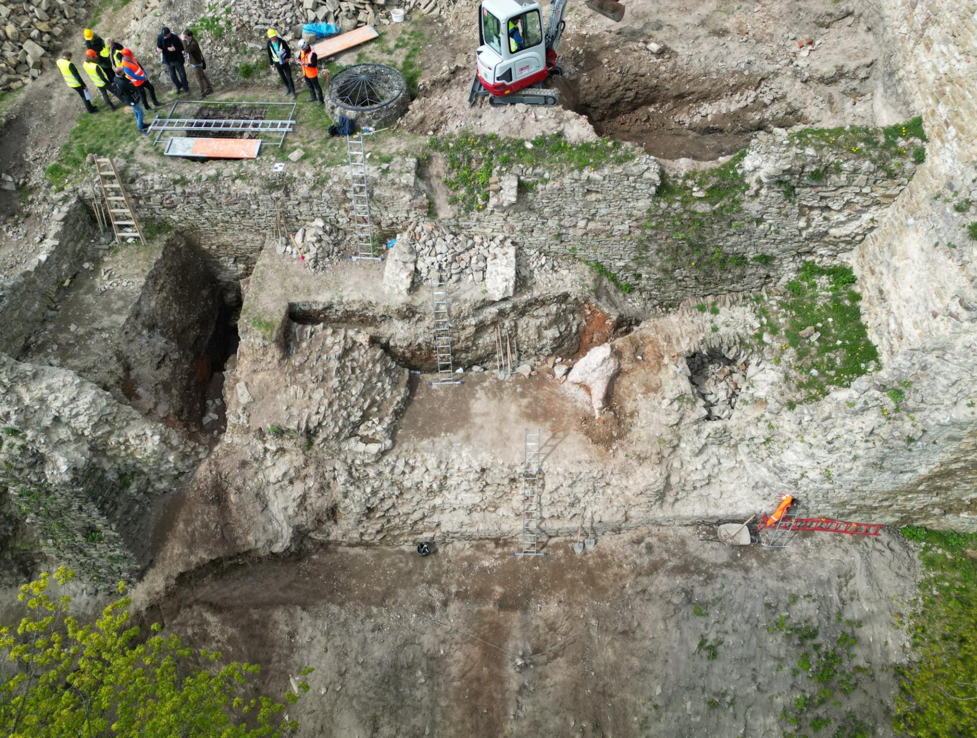
Severozápadná hradba IV. nádvorie hradu Stará Ľubovňa
