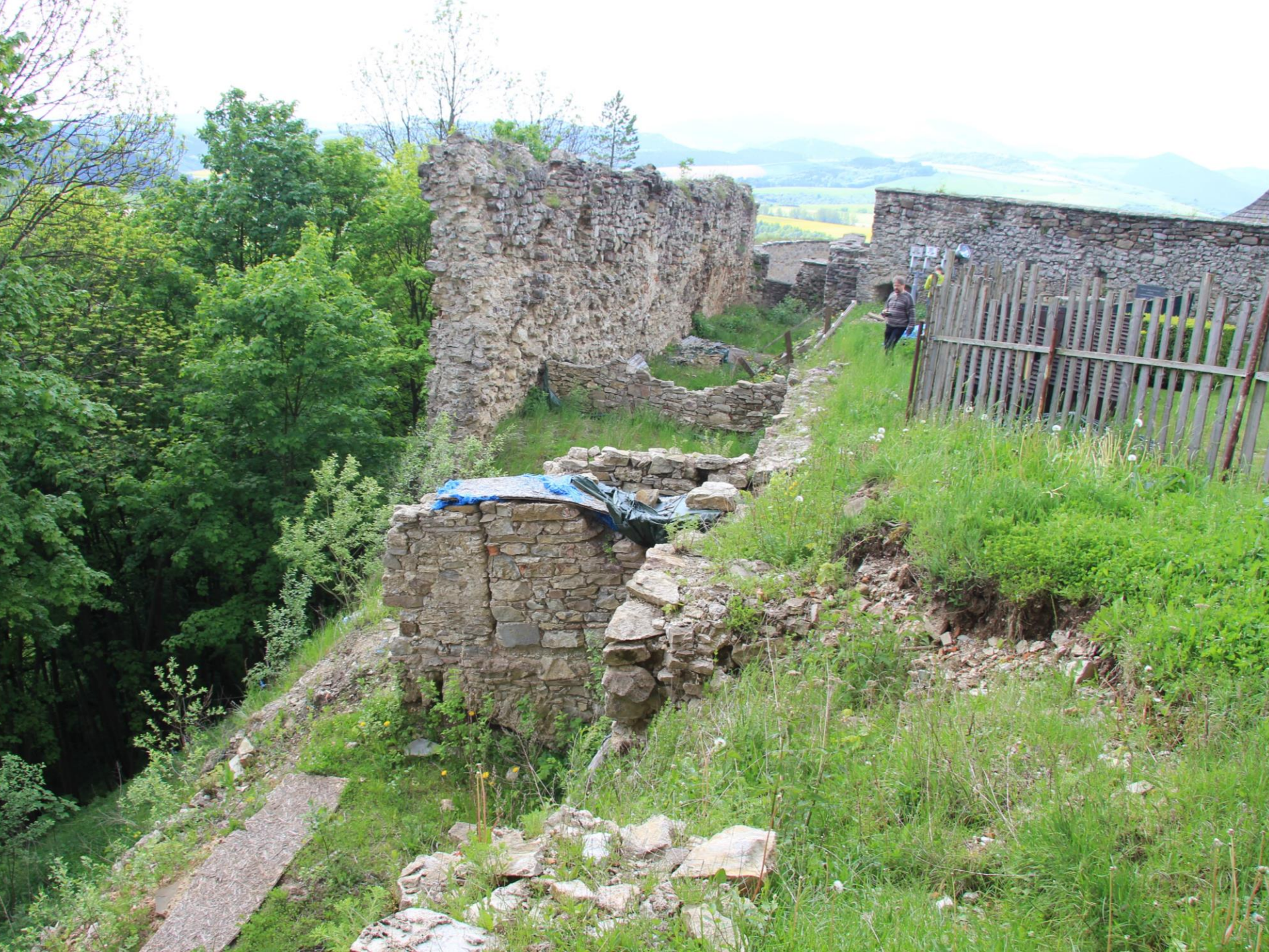
Severozápadná hradba IV. nádvorie hradu Stará Ľubovňa
