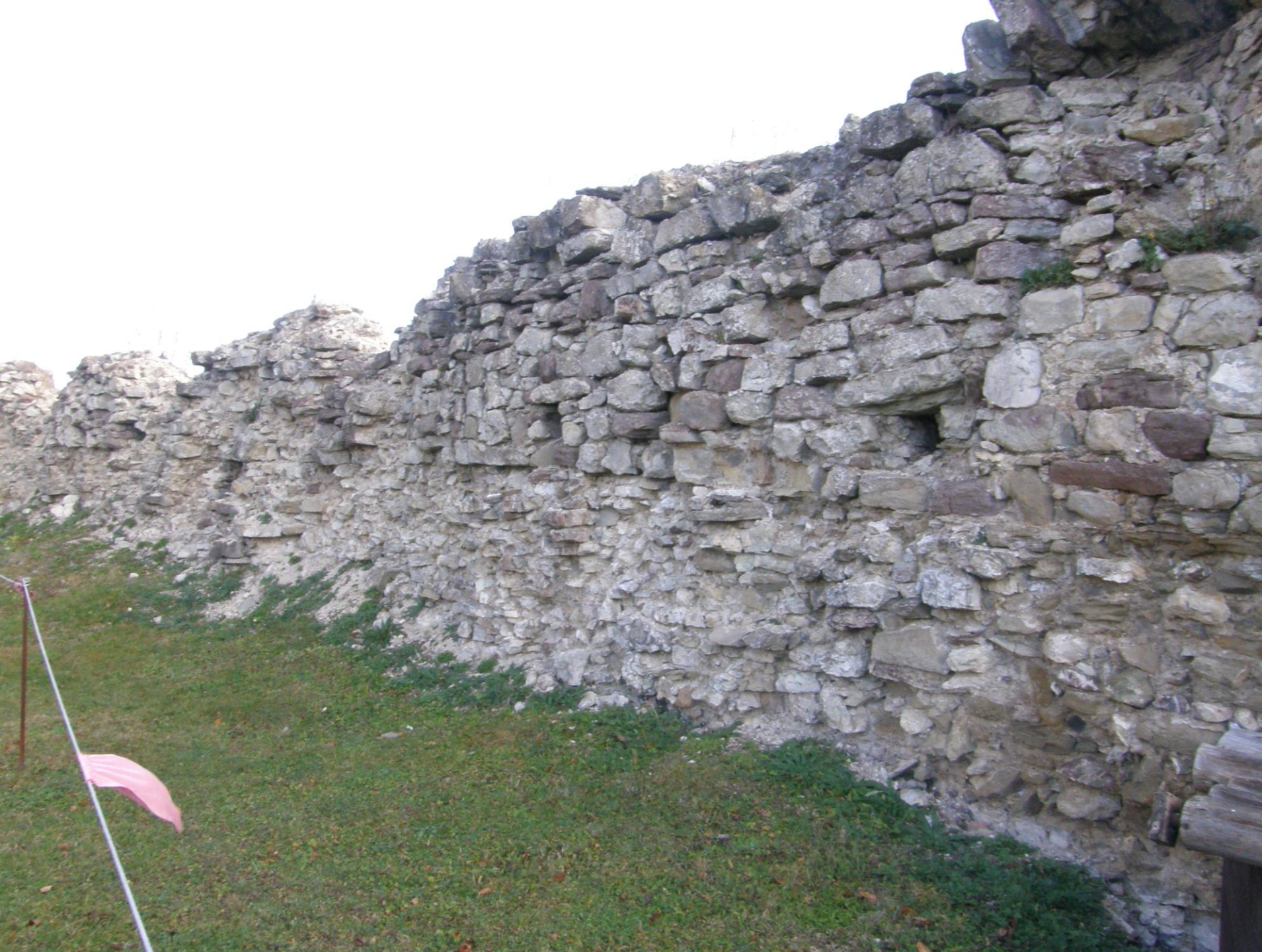
Severozápadná hradba IV. nádvorie hradu Stará Ľubovňa
