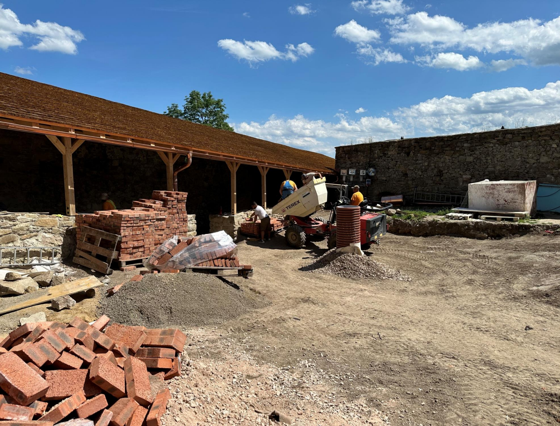
Severozápadná hradba IV. nádvorie hradu Stará Ľubovňa
