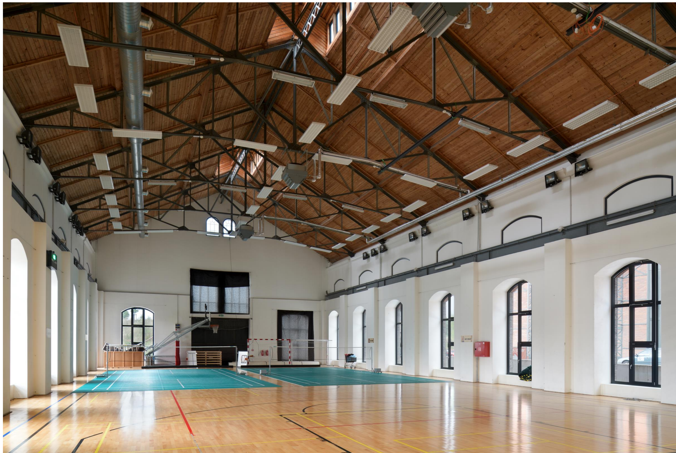
Ostrava, energetické ústředny Žofinské huti a koksovny Karolina / Trojhalí, stav po konverzi, arch. Josef Pleskot, 2014 Kulturní památka
