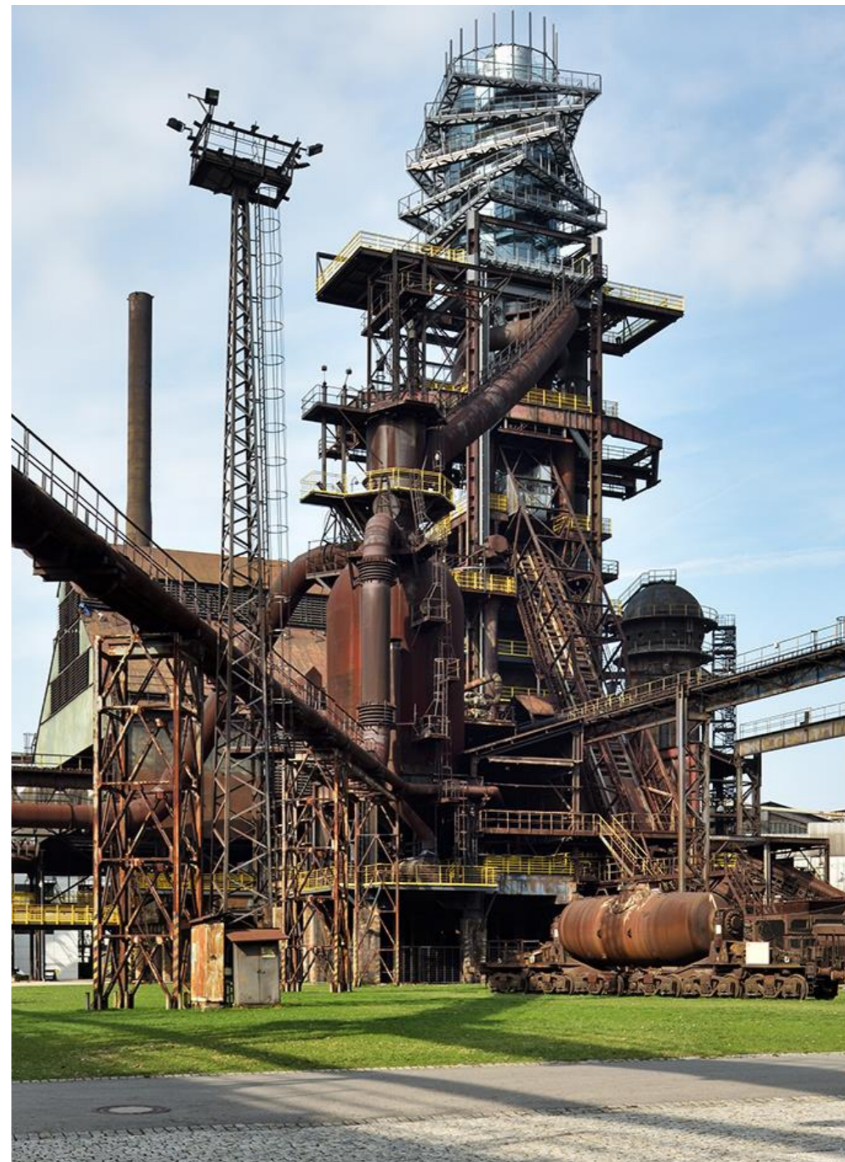
Konverze jednotlivých objektů Vysoká pec č. 1, arch. Josef Pleskot, 2015
