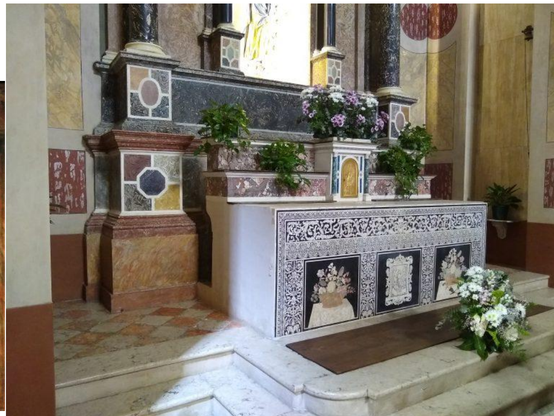
Scagliola použitá pro obklady oltáře imitující barevné mramory, Guido Fassi, Cattedrale dell'Assunta – Duomo, Carpi, 1629. (Antependium od Giovanni Gavignani, 1670s, první generace mramorářů).
