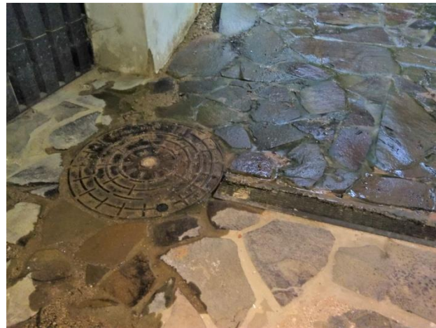
Jeden z dôvodov vlhkosti v podzemí
