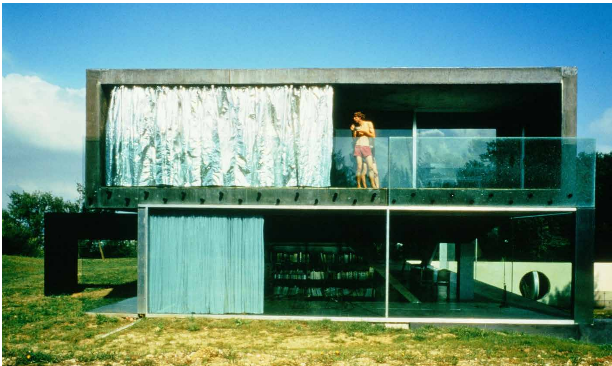
obr: Maison à Bordeaux, OMA, 1998 zdroj: OMA
