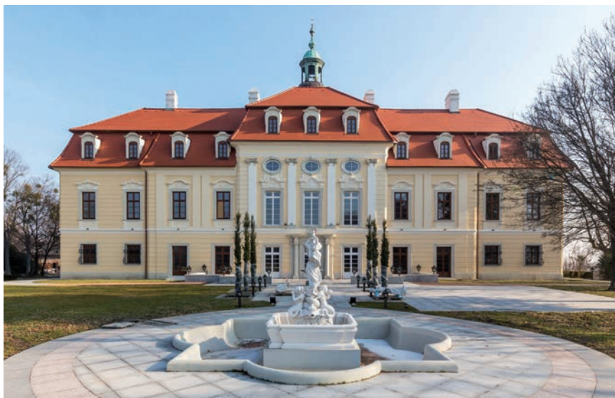
Bernolákovo, súčasný stav záhradnej fontány s parterom po obnove v roku 2016. Foto Jozef Lenhart
